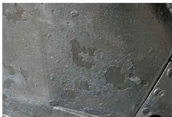
Fig.11. Zone de délamination du feuil supérieur de peinture (NUM20080463)
