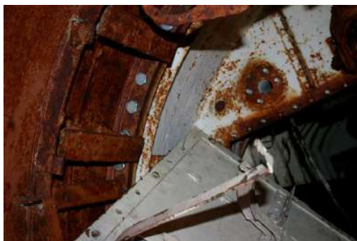
Fig. 18. Vue des parois du compartiment central (les boulons assurant la liaison entre les deux compartiments sont visibles à gauche de l'image). (NUM20080468)
