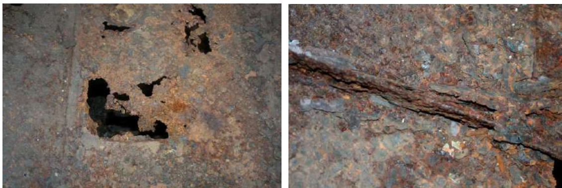
Fig. 15 et 16. Vues du plancher dans le compartiment central (NUM20080466 et NUM20080467)
