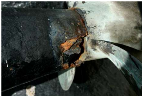
Fig.10. Corrosion galvanique au niveau de l'arbre d'hélice (NUM20080462)
